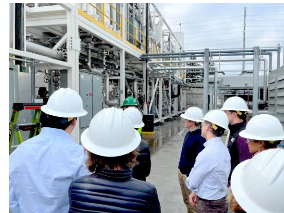
10MW プラント
